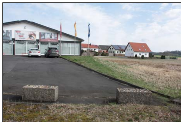
Abb. 4: Bestandsgebäude und PKW-Stellplätze des Einzelhandels
