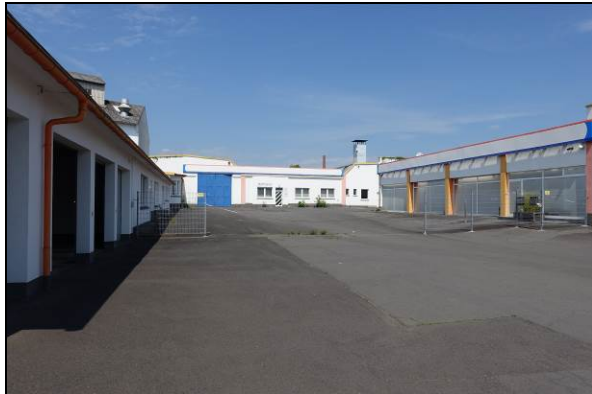
Foto 1: Versiegelte und überbaute Flächen im östlichen Plangebiet
