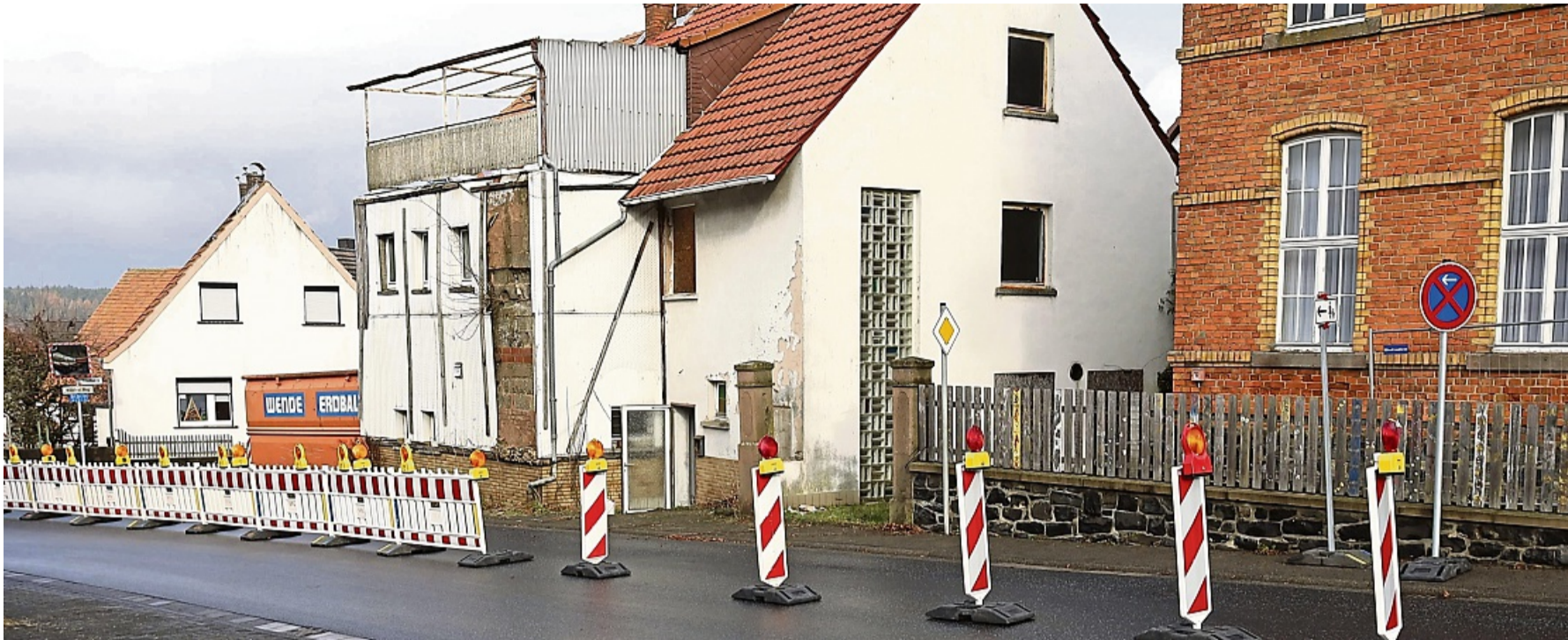
Ein Schandfleck in der Werngeser Ortsdurchfahrt verschwindet.
