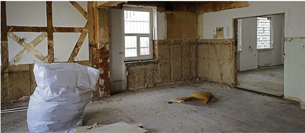
Das Gebäude ist bereits entkernt.
