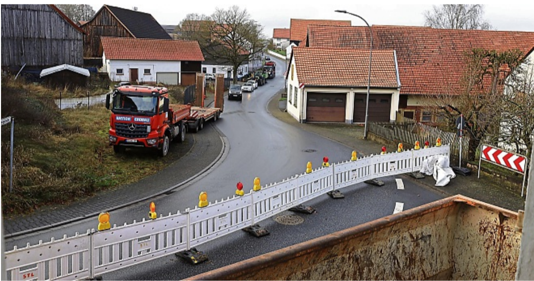
Der Abbruch des Gasthauses Kröll hat begonnen. Die Willofser Straße ist gesperrt, der Verkehr auf der Kreisstraße 72 wird mit Ampeln geregelt.
