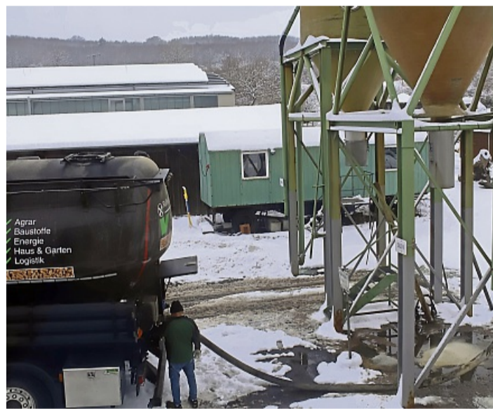
Die beiden Salzsilobehälter werden gerade befüllt. Das zu beladende Streufahrzeug fährt darunter, das Salz fällt auf die Ladefläche.
