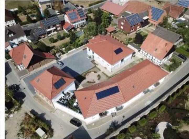
Blick von der Straße auf die Anlage
